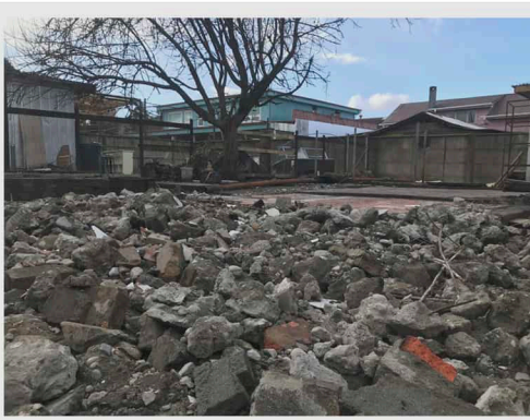
Proyecto en curso - Reconstrucción de Restaurante Alto Cafe. Integrar los residuos de la demolición a la capa de relleno inferior del proyecto, reduce el impacto ambiental, disminuye los costos de disposición y transporte, y mejora la eficiencia del proyecto.-
